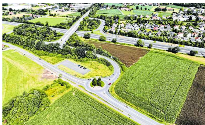
Der Kreisverkehr auf der Osnabrücker Straße wird in den kommenden vier Wochen saniert. Foto: Gerald Dunkel
