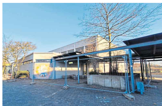
Die Sporthalle in der Mark in Kirchlengern wird saniert.
