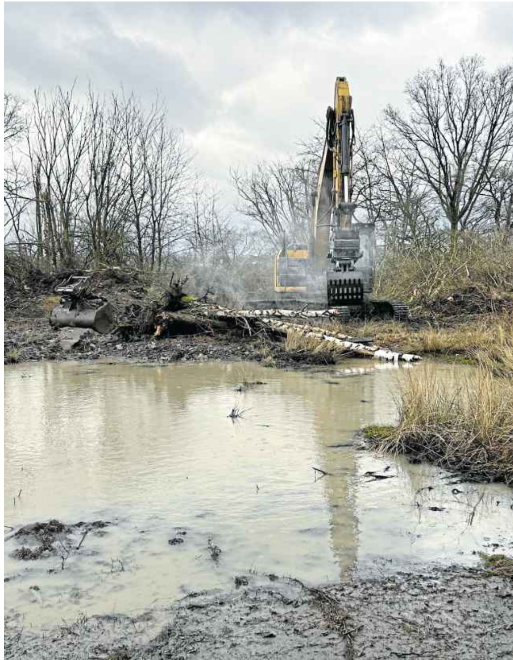
Ein Bagger entfernt in der alten Tongrube die Gehölze mit den Wurzeln. Foto: Karin Bohrer/ Kreis Herford
