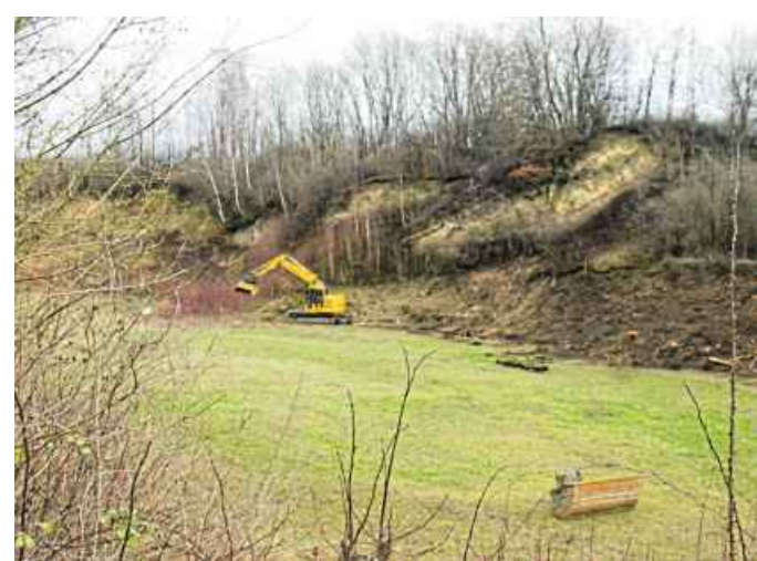
Dieser Bagger ist mit einer Fräse ausgestattet, die das Gehölz umgehend zu Mulch verarbeitet. Foto: Meiko Haselhorst
