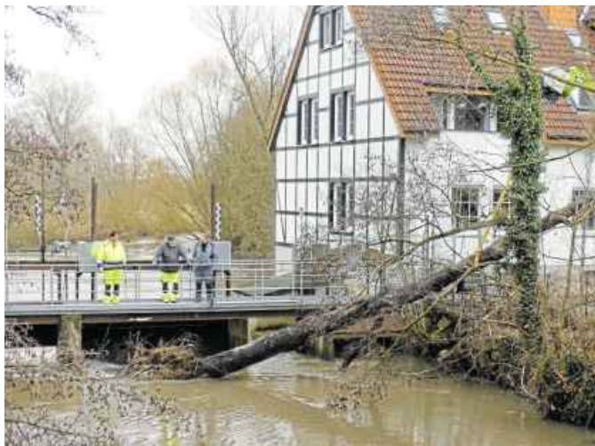
Anfang Februar 2021 wird ein umgestürzter Baum vor dem Elsewehr geborgen.
