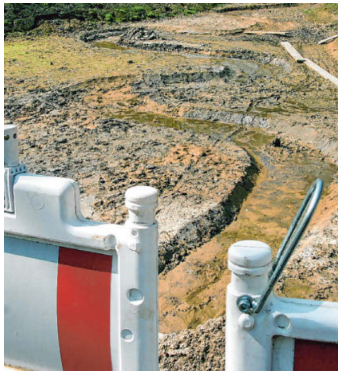
Renaturierung: An der Tannenhöhe wird direkt an der Brücke dafür gesorgt, dass der Bach künftig wieder mäandriert.
